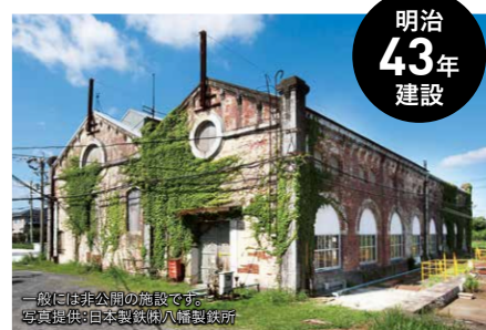
中間市 遠賀川水源地ポンプ室
