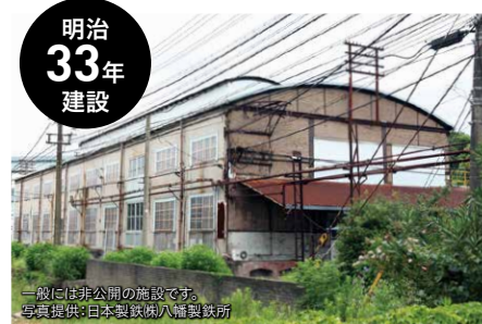
北九州市八幡東区 官営八幡製鐵所 旧鍛冶工場
